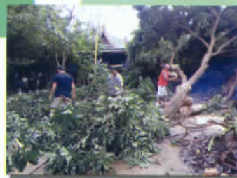
ตัดต้นไม้โค่นล้ม
