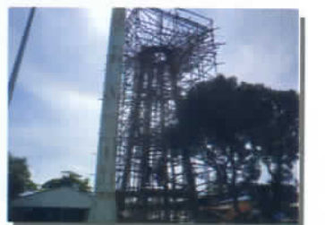
ก่อสร้างประปา ม.๖
