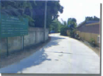
ซ่อมผิวจราจร คสล. ม.๒
