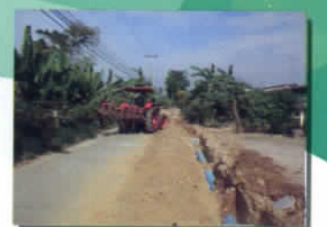
ฝังท่อระบายน้ำพร้อมบ่อพัก ม.๘
