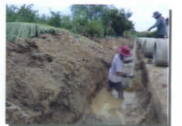
ฝังท่อระบายน้ำ คสล. ม.๖
