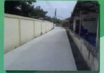
ปรับปรุงถนนผิวจราจร คสล. ม.๓
